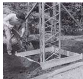
KT-C タワーのコンクリート基礎 (参考図)
