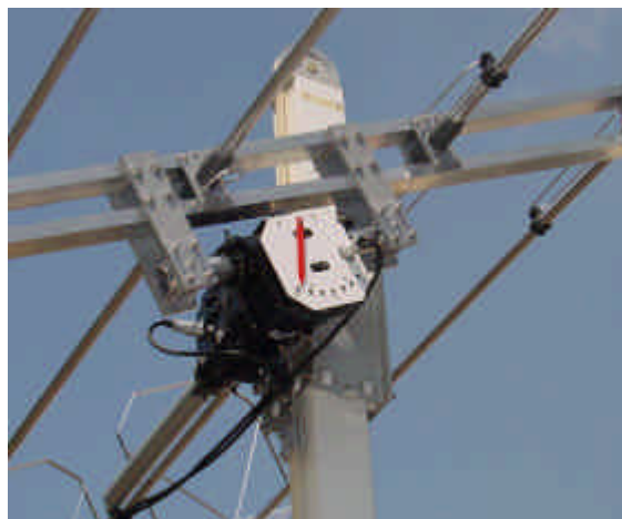
アンテナの支持部のトラックにはチルト偏波可変用ローテータが搭載
